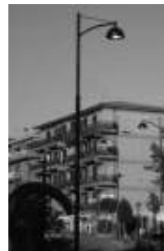
Figura 6.23 - palo con sbraccio ed armatura cut off
