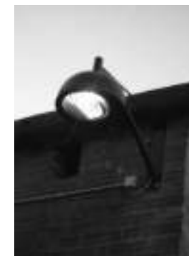
Figura 6.24- sbraccio a muro con armatura cut off
